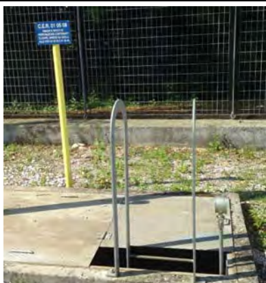
Vasca separazione olio - acqua CN4 bis
