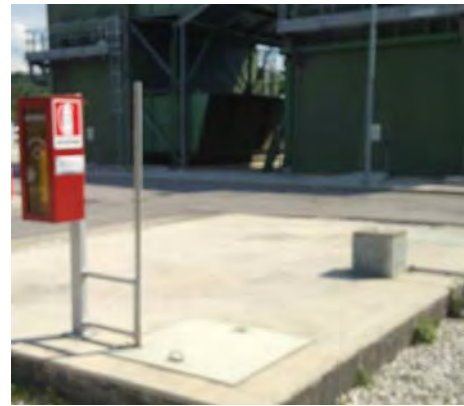
Vasca drenaggi acqua da rigenerazione
