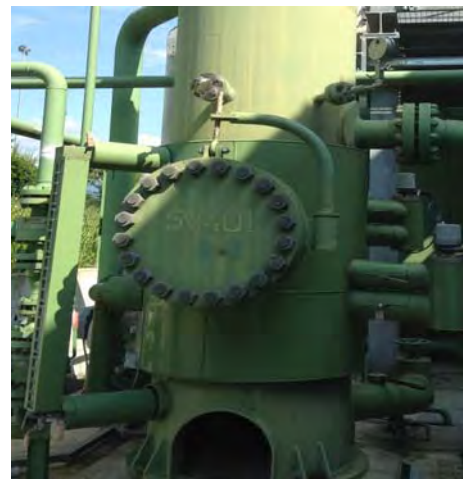
SV401 separatore aspirazione 401
