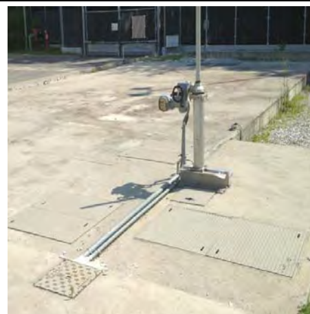
Vasca acqua prima pioggia
