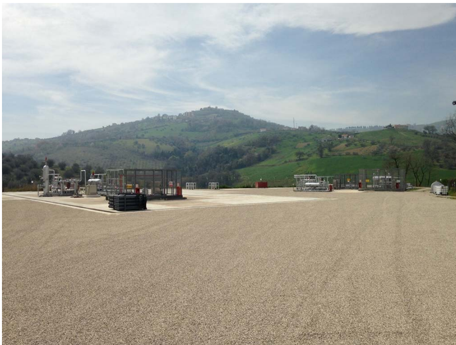
Area pozzi CLI 36; CLI 25 e CLI 29 dopo l'attività di sidetrack
