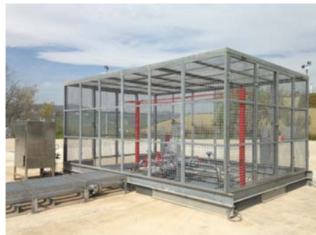
Di lato il pozzo Cellino 36 dopo l'intervento
