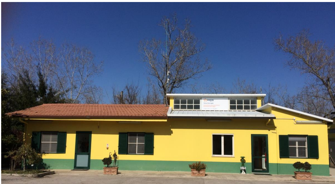
Vista frontale palazzina uffici Cellino
