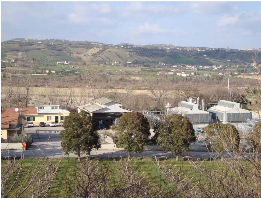
Vista della centrale
