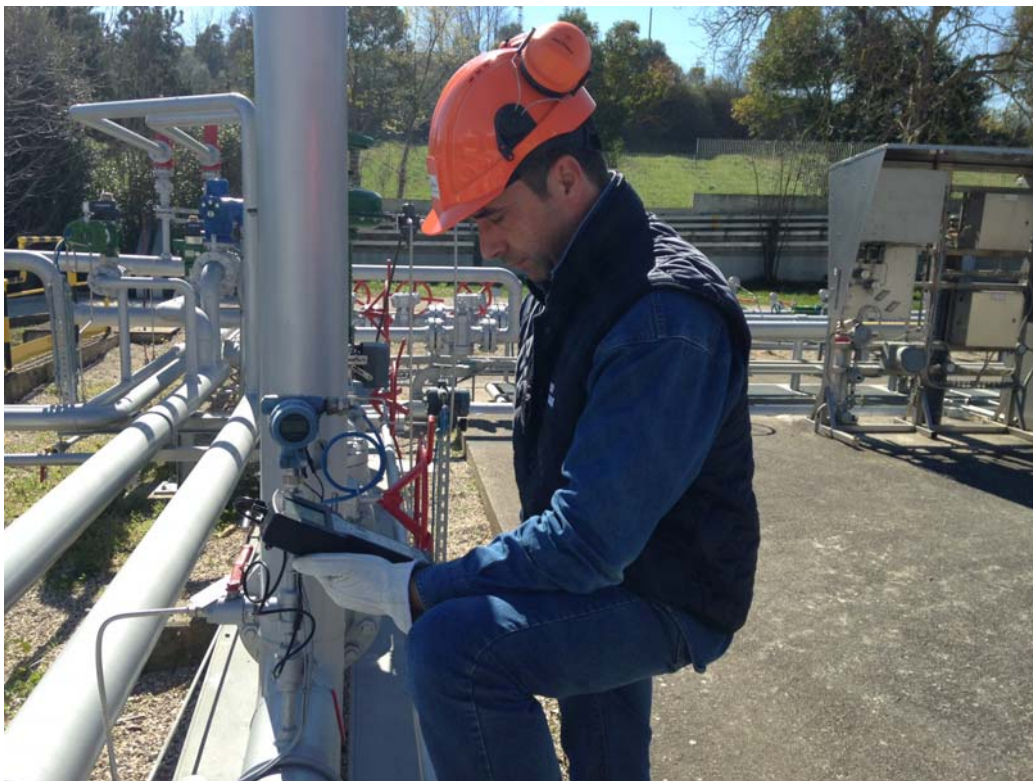
Personale dell'impianto intento nella taratura di un trasmettitore di pressione.
